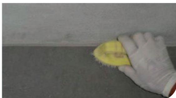
Limpeza da junta de dessolidarização
