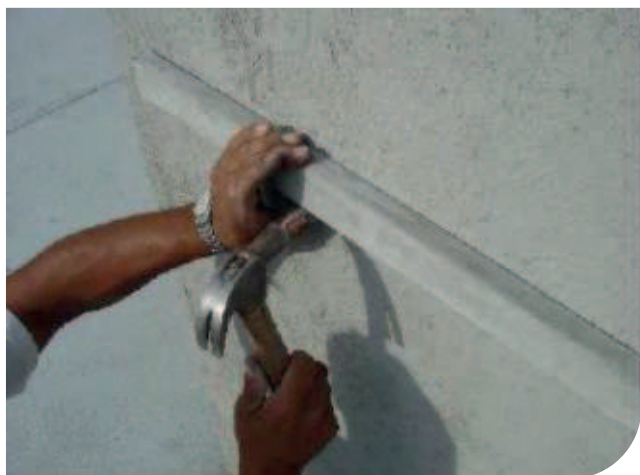
Fixação da régua metálica
