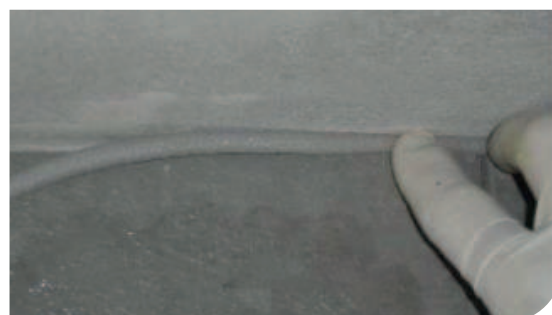
Inserção do limitador de fundo de viga
