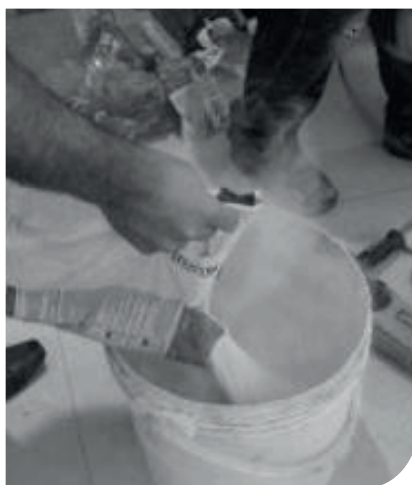
Preparo da argamassa colante – adição do pó
