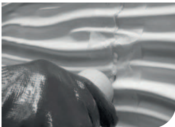
Aplicação do rejunte com bisenaga
