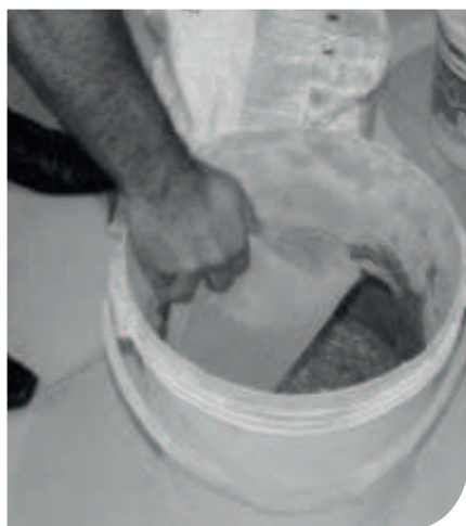
Preparo da argamassa colante – adição da água
