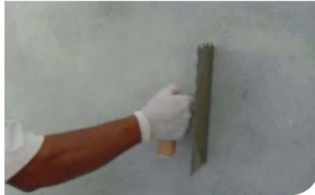
Remoção de objetos aderidos com espátula metálica
