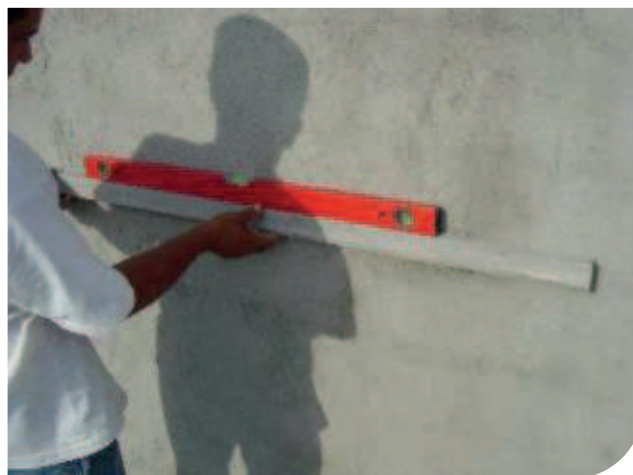
Conferência do nível da régua metálica
