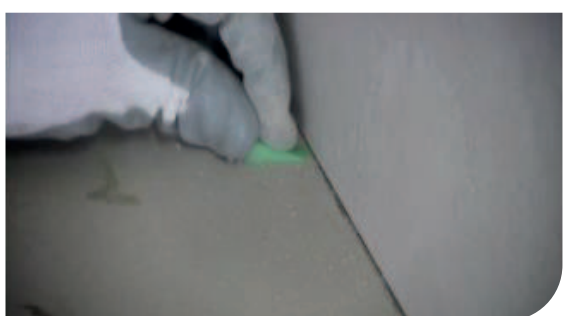
Colocação dos calços para apoio das peças
