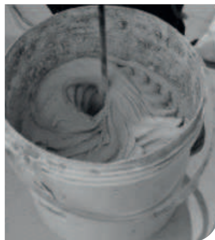
Mistura com haste helicoidal, formando uma pasta homogênea
